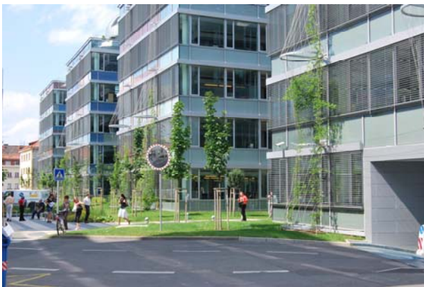
Foto 2: La sede de la empresa de la compañía de seguros más grande en la República Checa puede producir un mejor balance energético de 60% gracias a la automatización en red de todas sus funciones del edificio a través de KNX.
